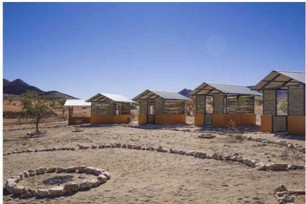
Hütten mit Betonbetten
